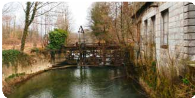
▷ L'ancienne installation hydroélectrique avant transformation
