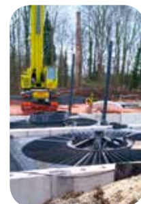
▷ Pose des deux groupes VLH en décembre 2011
