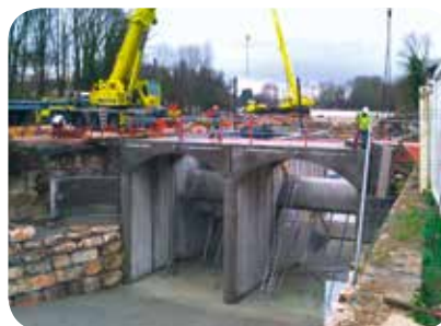
▷ A l'intérieur de la propriété, le pont de circulation a été démolé puis reconstruit afin de modifier la taille de la pile centrale et permettre une meilleure circulation de l'eau dans les VLH
