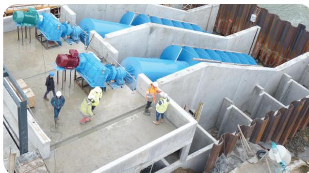
➤ Installation des vis hydrodynamiques et construction de la passe à poissons à bassins successifs (en bas à droite)
