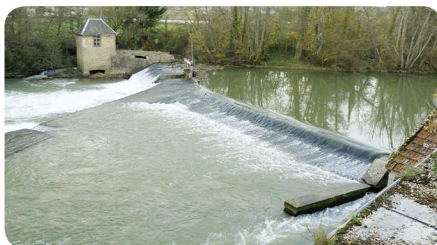
➤ Vue avant travaux : le barrage et, au fond, l'ancienne centrale qui sera remplacée par deux vis hydrodynamiques et une passe à poissons
