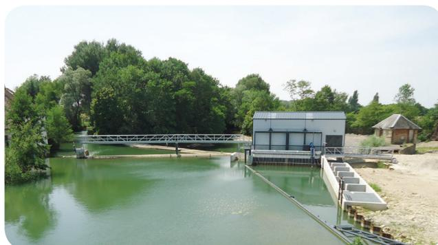
➤ Vue d'ensemble après travaux : prise d'eau avec drome et dégrilleur, passe à poissons à bassins successifs, local technique avec passerelle d'accès
