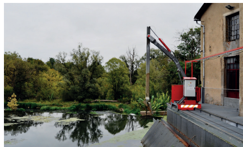
▷ Prise d'eau avec le dégrilleur automatisé et en fond l'un des 3 seuils de retenue de la centrale
