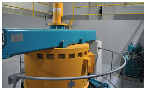
▷ La centrale a été remise à neuf avec 2 groupes hydroélectriques de 200 kW unitaire
