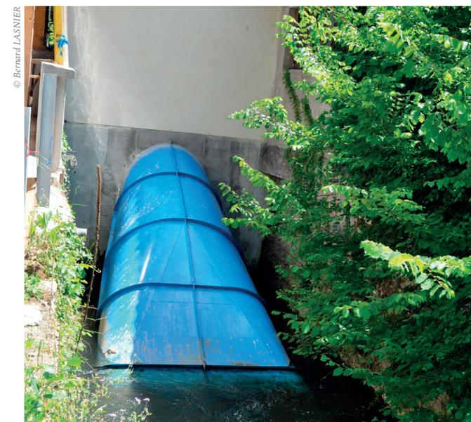
▷ Arrière du local technique rénové avec la sortie en siphon du groupe hydroélectrique
