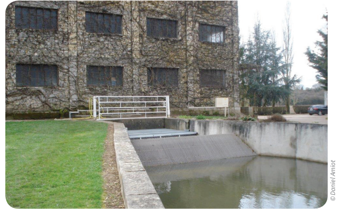
➤ Vue de la prise d'eau rénoverée et ichtyocompatible avec la grille inclinée
