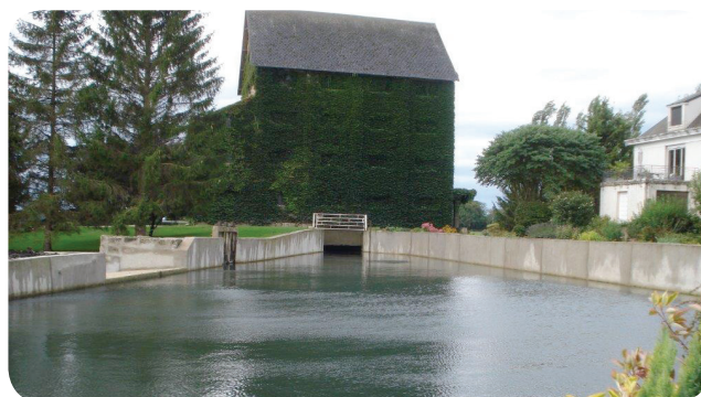
➤ Vue d'ensemble de l'ancien moulin à farine avec l'entrée d'eau aménagée
