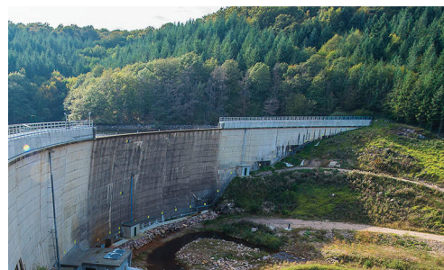
▷ Au pied du barrage : l'évacuation du trop plein et le local technique de la centrale
