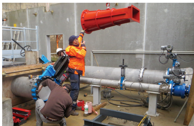
▷ Travaux d'installation de la turbine en 2017
