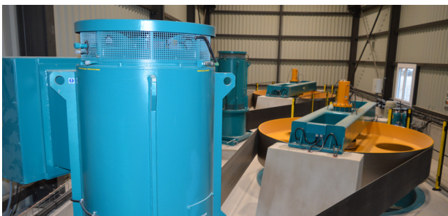
Installées dans un bâtiment neuf, les deux turbines verticales Kaplan double réglage maintiennent la production à faible débit et lorsque la chute diminue.
