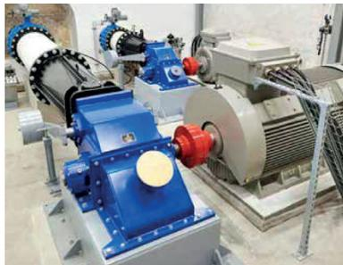
Centrale de Consolation-Maisonnettes (25) : remise à neuf d'une partie du canal d'amenée, de la chambre d'eau, de la conduite forcée sous 63 m de chute, des turbines, génératrices, équipements électriques et automatismes.
