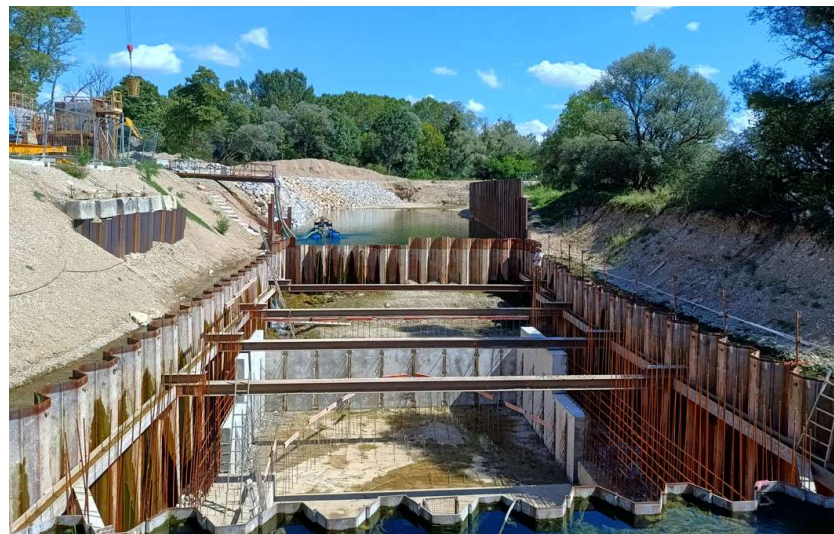
Chantier de construction de la centrale d'Ounans (39).
