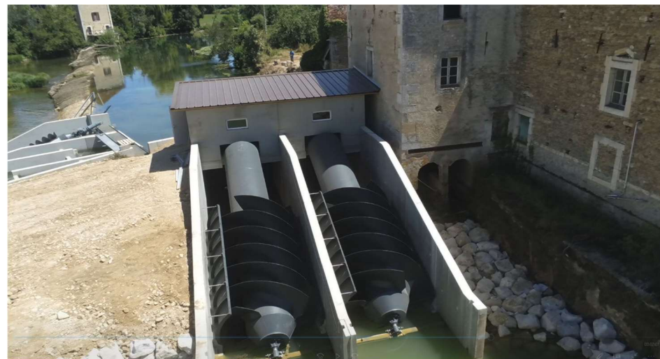
Fin de chantier de la centrale Roffey (89).
