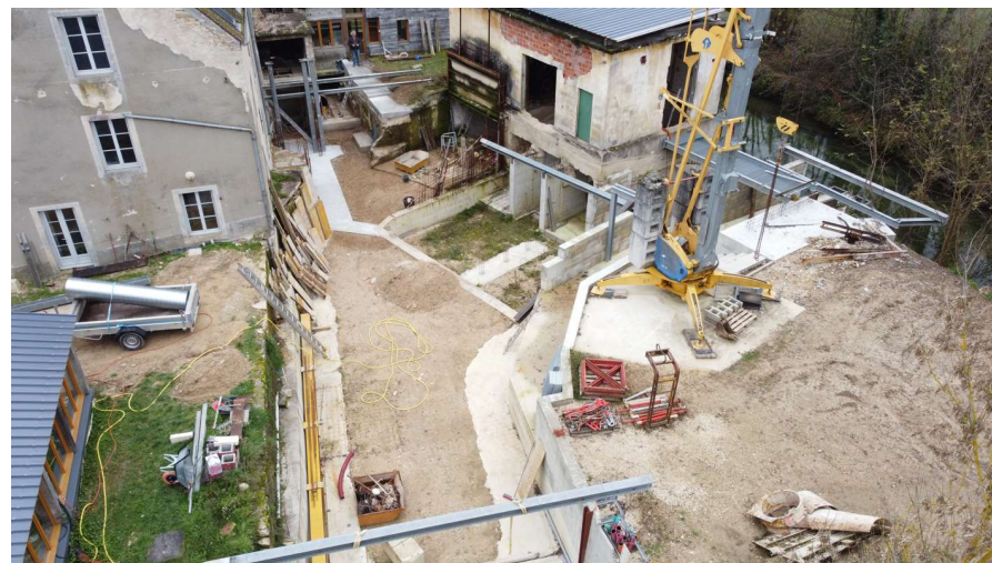
Chantier de construction de la centrale de Cessey-sur-Tille (21).
