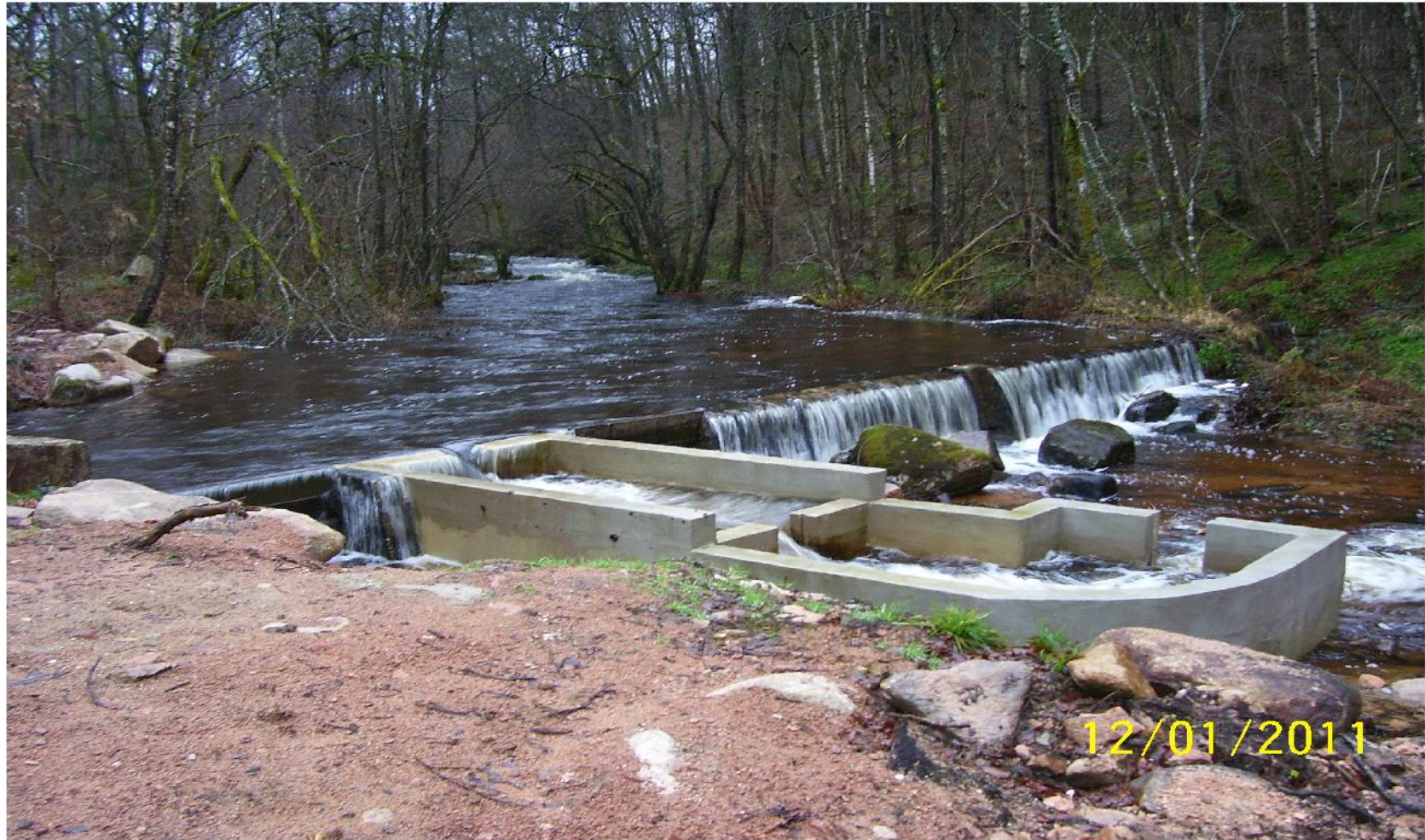
Le barrage (hauteur 1 m) et la passe à poissons
