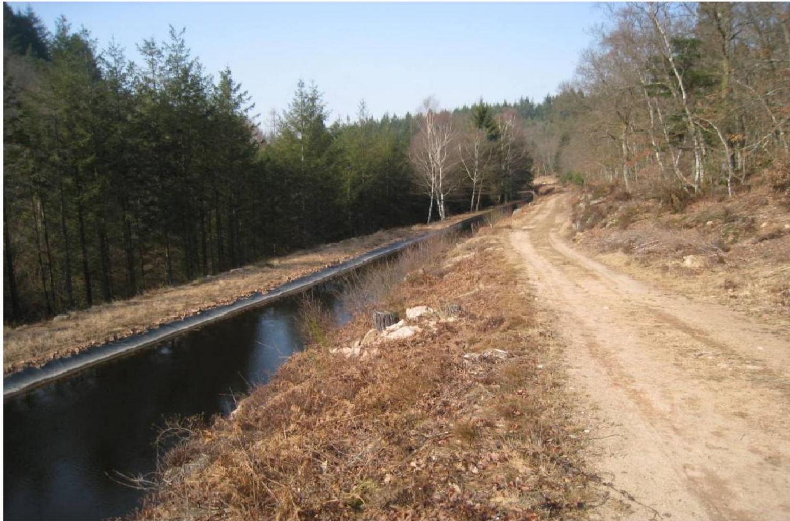
Le canal d'amenée (longueur = 1 km environ)
