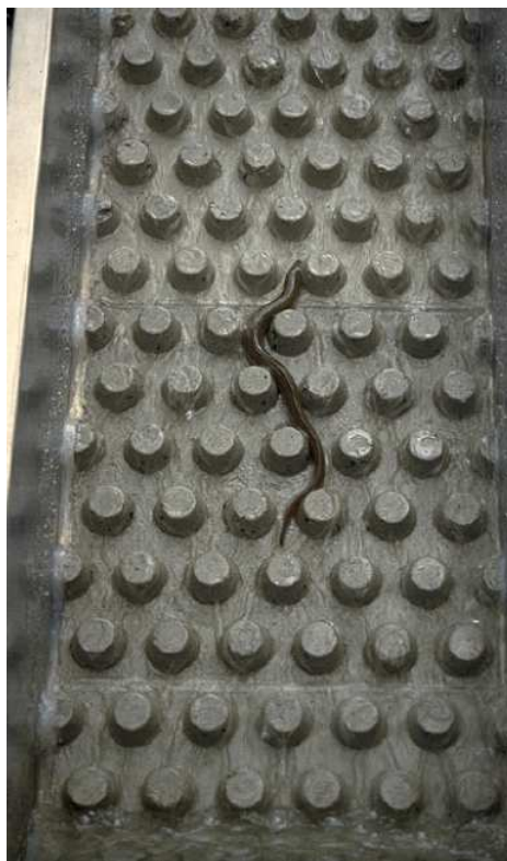
Anguilette utilisant une passe à plots
