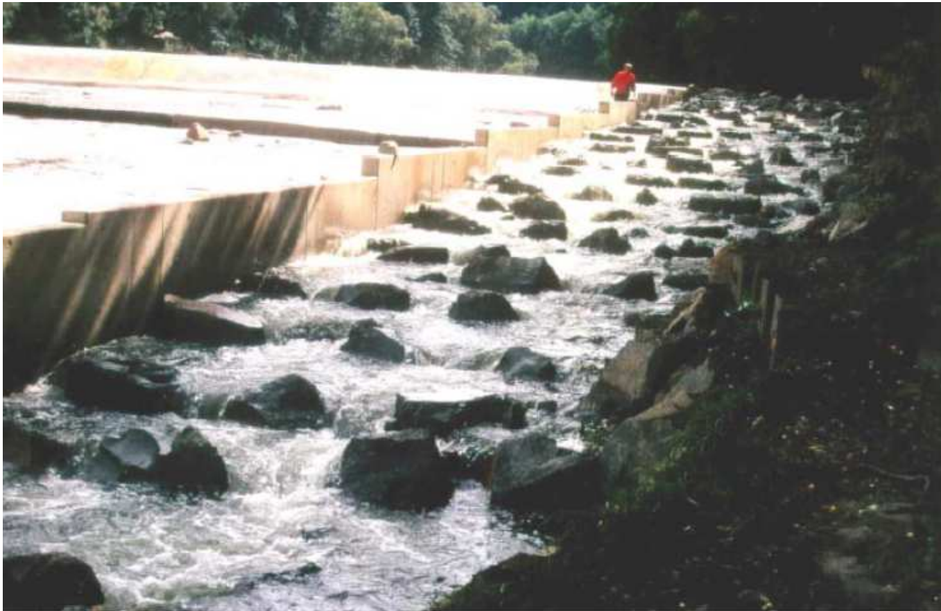
Enrochements en rangées périodiques
