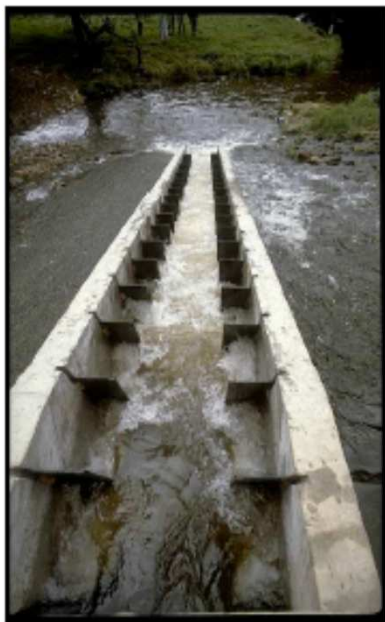
Ex : Passe à ralentisseurs plans
