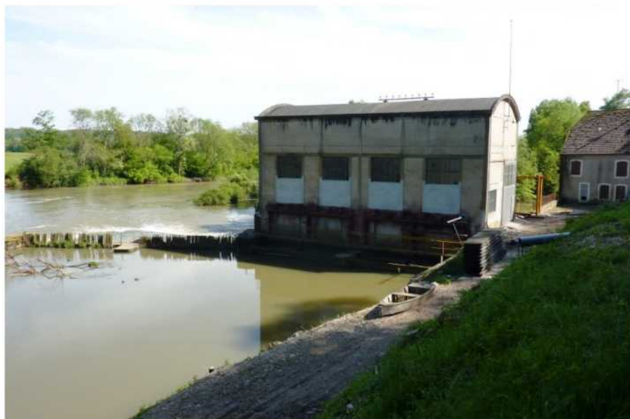
La centrale AVANT travaux
