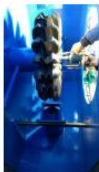
Centrale idroelettrica di Capriolo (2017) Potenza 100 kW Produzione annua 350MWh
