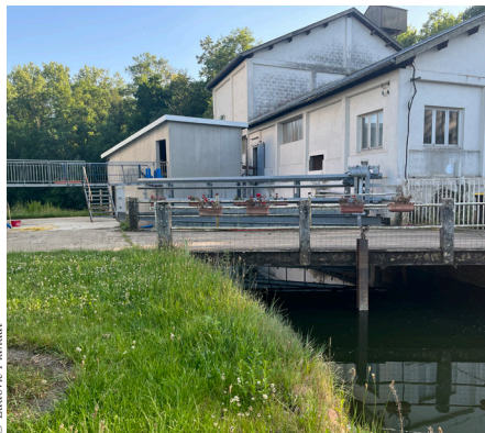
La nouvelle Kaplan (bâtiment au centre de la photo) a été installée sur le canal de décharge de la centrale existante.
