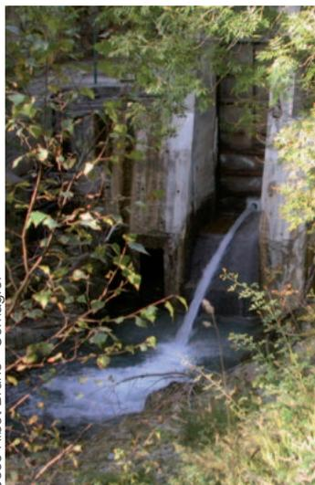
Fig. 8.6 - Délivrance d'un débit minimal par orifice calibré sur le Vicdessos (Ariège).
