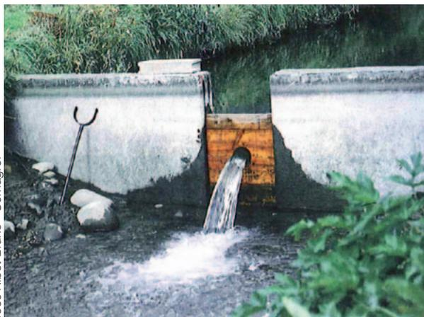
Fig. 3.3 - Plaque à orifice insérée pour le jaugeage capacitif.
