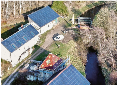
En plus de la centrale hydroélectrique de 150 kW, les toitures du moulin Simonot sont recouvertes avec 450 m 2 de tuiles photovoltaïques, hormis celle que Régis Boutry a restaurée avec des tuiles émaillées.
