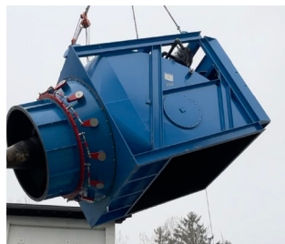
► Grutage de la turbine Kaplan double réglage
