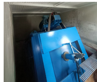
► La turbine Kaplan inclinée entraîne une génératrice asynchrone après multiplication par poulies-courroie
