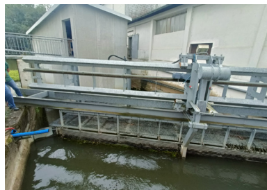
► Le dégrilleur et la grille verticale à barreaux horizontaux. Les feuilles et les bois sont poussés vers la vanne porte située à gauche
