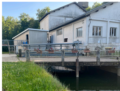
► La nouvelle centrale (petit local au pan de toiture incliné) abritant la turbine Kaplan à été construit à l'emplacement des anciennes vannes de décharge
