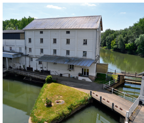
► Vue du bâtiment abritant les turbines Francis, avec étages transformés en habitation, avant implantation de la turbine Kaplan à la place de la vanne située à droite sur la photo
