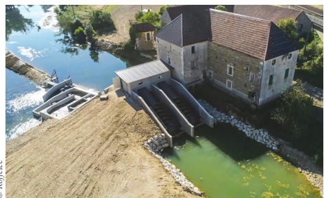
© Roffelec L'installation, comprenant 2 vis principales et une vis sur le débit réservé positionnée à côté de la passe à poissons, produit 600 000 kWh/an en moyenne. Le défeuillement est assuré par un jeu d'ouverture et de fermeture des vannes.
