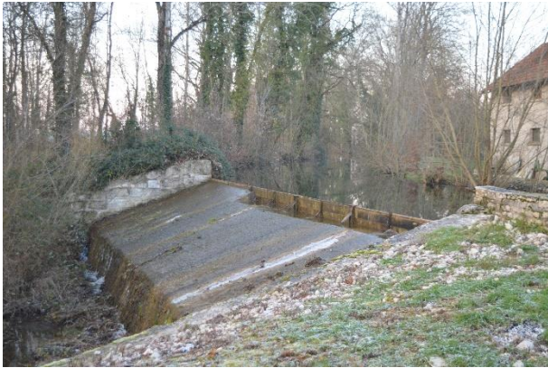
Déversoir de décharge du canal d'amenée
