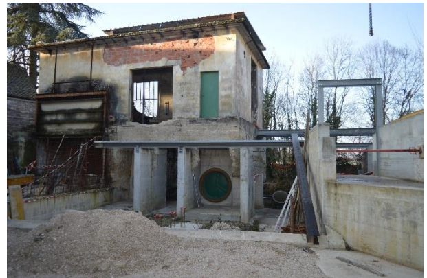
Chantier sur les chambres d'eau
