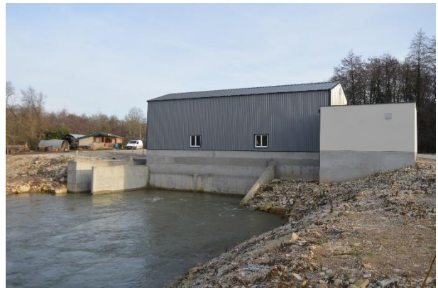
Canal de fuite et bâtiment de la centrale
