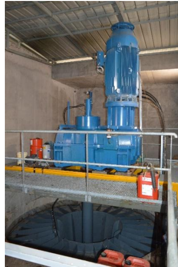
Turbine, multiplicateur, alternateur et vue sur le toit amovible
