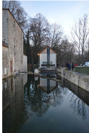
Prise d'eau de la centrale et vue sur le dégrilleur
