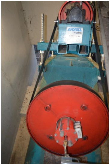
Turbine Kaplan simple réglage
