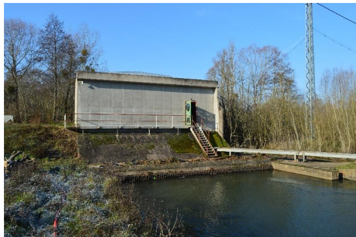
Prise d'eau et vue sur la centrale
