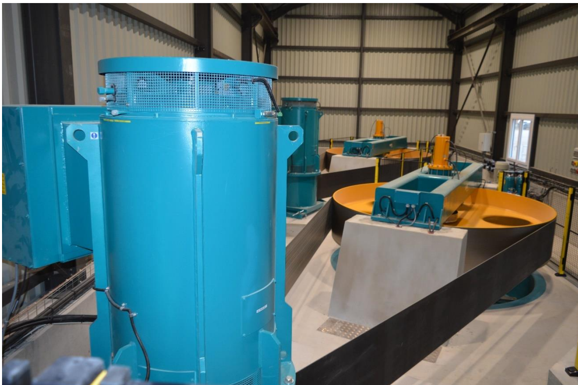
Turbines Kaplan double réglage avec entraînement par poulie-courroie et génératrices
