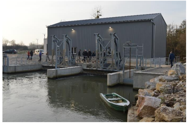
Prise d'eau de la centrale avec les dégrilleurs
